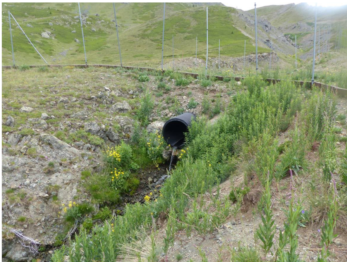
Tubazione di attraversamento rio alla confluenza pista 100Alta con pista 100 Alta Variante (HDPE D=100mm)
