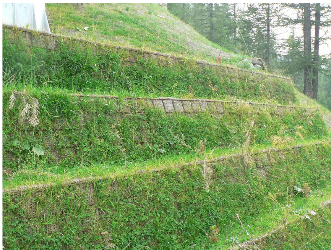
Fig.30. Esempio di terra rinforzata in alta quota a Bardonecchia
